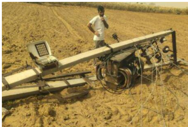
निगम को भी भारी नुकसान उठाना पड़ा। बिजली निगम के एसडीओ कर्बल ने बताया कि तेज आंधी के कारण निगम के करीब 340 बिजली पोल टूटकर गिर गए, जबकि विभिन्न फीडों को विद्युत आपूर्ति देने वाले करीब 50 ट्रांसफार्मर भी जमीन पर गिरकर क्षतिग्रस्त हो गए। प्रारंभिक
